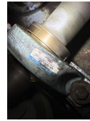
Ah10 supply fan DE. P2B-GTAH-207 Dodge
