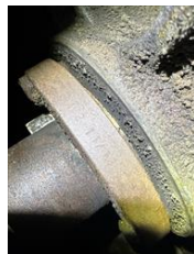
8 supply fan shaft hub. 2 11/16
